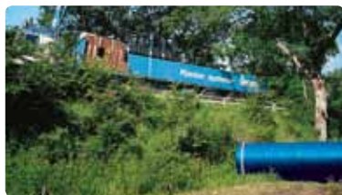
Rørmodtagelse og modtagelseskontrol.
