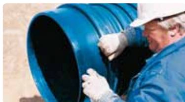
Kontrol og smøring af spidsenden.
