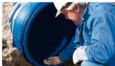
Kontrol og smøring af pakning.
