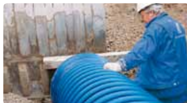
Kontrolleret montering med gravemaskine.
