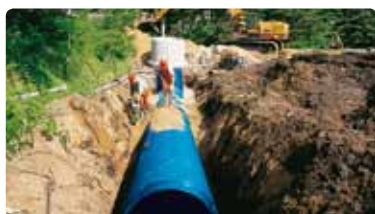
Fyldning, kontrol af riller og tryktest.
